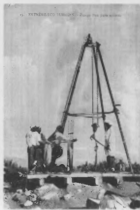
Forage d'un puits artésien.
