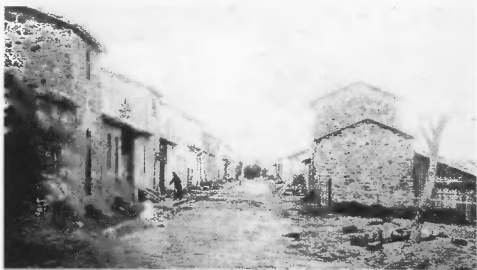
Grande rue à Haussonvillers.
