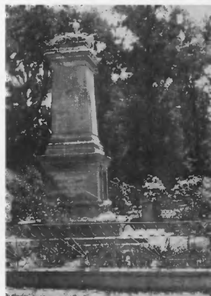
Le Monument de Camp-du-Maréchal.
