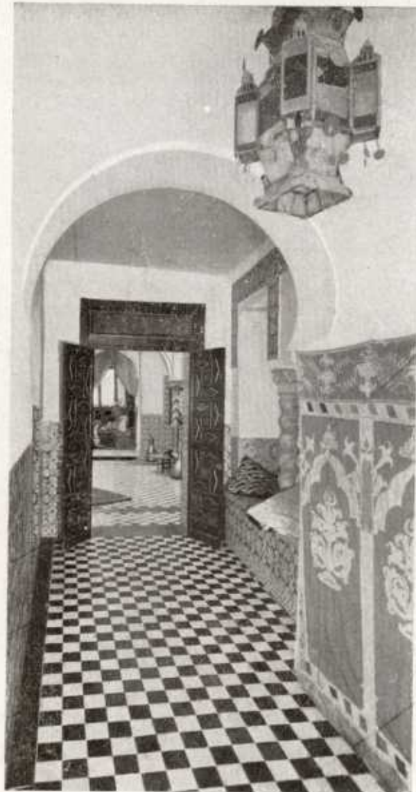
PL. 5 — Couloir donnant entrée dans le patio
