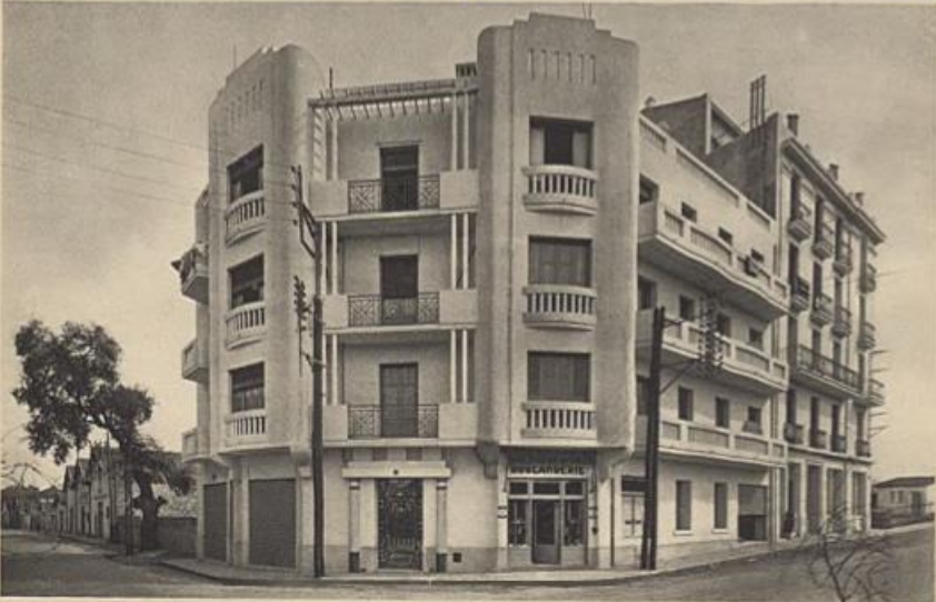
En haut et à gauche : M. FERLIE, Architecte ; PAINDAVOINE Frères, Constructeurs Métalliques. En haut et à droite : M. SALVADOR, Architecte ; Ateliers DURAFOUR, Constructeurs Métalliques. En bas : M. NARDI, Architecte ; MENIN, DELENSIGNE & Cie, Constructeurs Métalliques. Photo EICHACKER.
