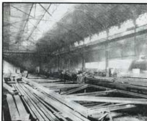
Hussein-Dey : Hall d'assemblage « Charpente »
