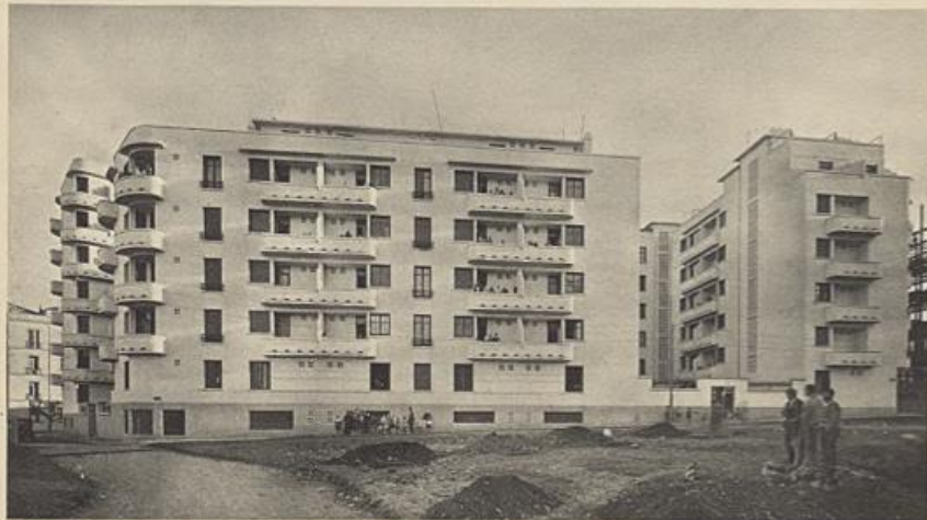
Inmeubles de rélogement, Groupe des Anciennes Messageries ; M. FERLIE, Architecte ; OYNIUM d'ENTREPRISES, Constructeurs Métalliques. Photo EICHACKER.
