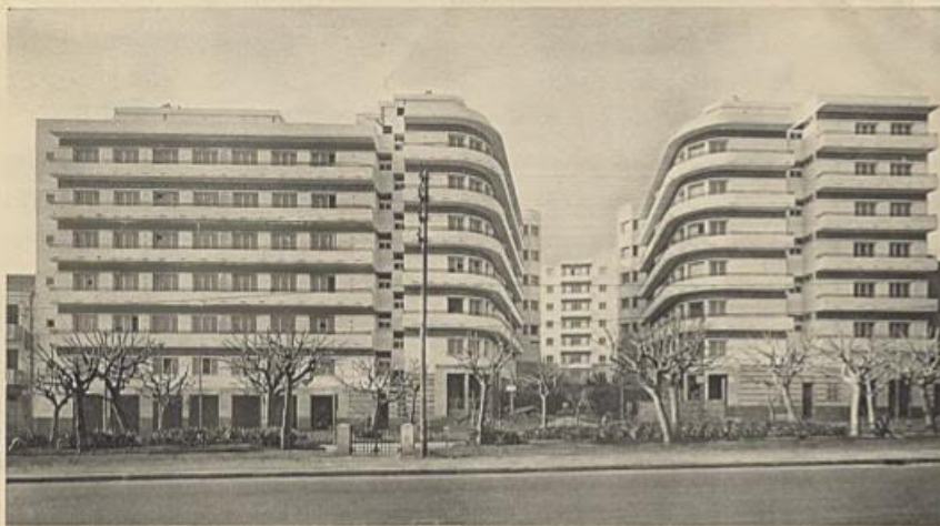
Inmeuble de rélogement, Groupe Matskof ; M. BIENVENJ, Architecte ; Ateliers DURATOUR, Constructeurs Métalliques. Photo EICHACKER.
