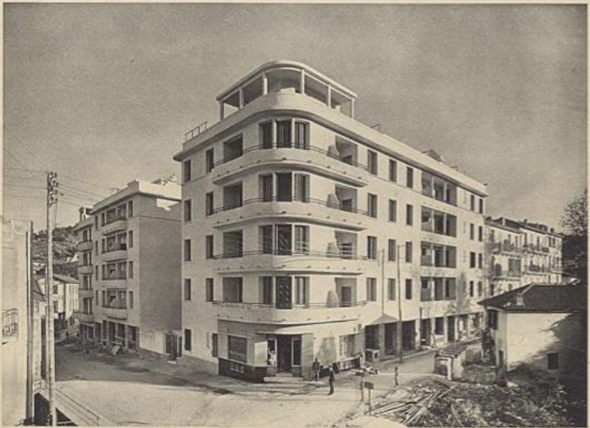
Immeuble de logement, Groupe rue Léon-Rochas, H. BEVIA, Architecte | FAINDOYONNE Frères, Constructeurs Métalliques. Photo EICHACKER.
