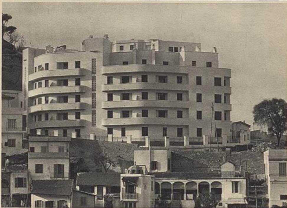
En haut : H. B. M. M. FERLIE, Architecte : Foray GARCIA, Constructeurs Métalliques. En bas : Cité ouvrière. M. FERLIE, Architecte : Ateliers DURAFOR Constructeurs Métalliques. Photos EICHACKER.
