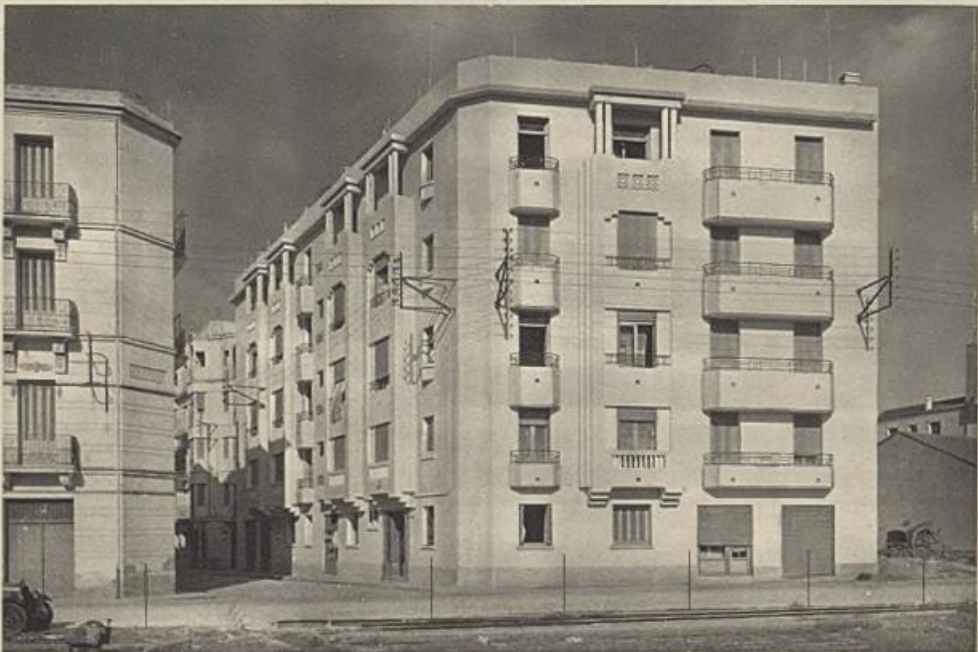
En haut et à gauche : M. MORESCHI, Architecte ; MENIN, DELENGE & Cie, Constructeurs Métalliques. En haut et à droite : M. JUANEDA, Architecte ; MENIN, DELENGE & Cie, Constructeurs Métalliques. En bas : MM. BRAHAU et RIPELLI, Architectes ; PAINDAVOINE Frères, Constructeurs Métalliques. Photos EICHACKER.
