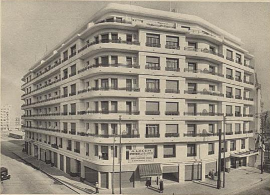
Ossature en acier. M. PRÉUILH, Architecte : Ateliers DURAFOUR, Constructeurs Métalliques. Immeuble terminé. M. PRÉUILH, Architecte : Ateliers DURAFOUR, Constructeurs Métalliques.
