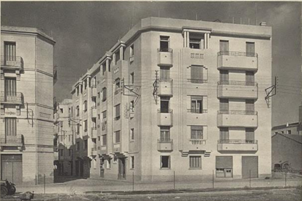
En haut et à gauche : M. MORESCHI, Architecte ; MENIN, DELENSEIGNE & Cie, Constructeurs Métalliques. En haut et à droite : M. JUANEDA, Architecte ; MENIN, DELENSEIGNE & Cie, Constructeurs Métalliques. En bas : MM. BRAHAU et RIPOLL, Architectes ; PAINDAVOINE Frères, Constructeurs Métalliques. Photos EICHACKER.
