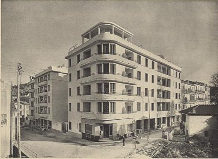
Immeuble de logement, Groupe rue Léon-Rochas, M. BEVIA, Architecte ; FAINDAVOINE Frères, Constructeurs Métalliques. Photo EICHACKER. 43
