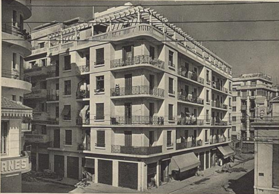
En haut et à gauche : M. ROGER, Architecte ; MENIN, DELENGE & Cie, Constructeurs Métalliques. En haut et à droite : M. ROSAZZA, Architecte ; Michel PANDOLFO, Constructeur Métallique. En bas : M. ROSAZZA, Architecte ; Michel PANDOLFO, Constructeur Métallique. Photos EICHACKER.
