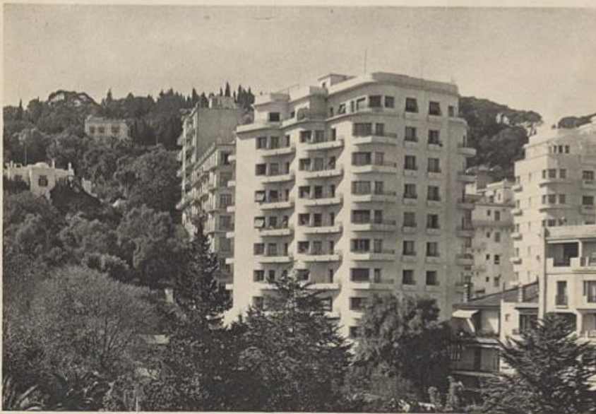
Immeuble sur le parc de Galland. 55
